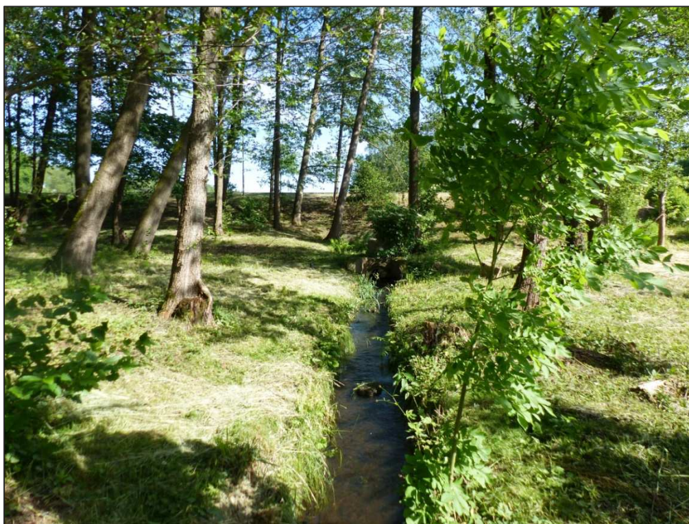
Obr. 6: SV koryto Hradčanského potoka pod hrází
