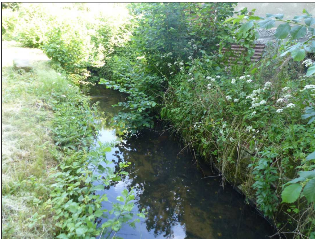
Obr. 5: JZ koryto Hradčanského potoka pod hrází, navržené ke zrušení
