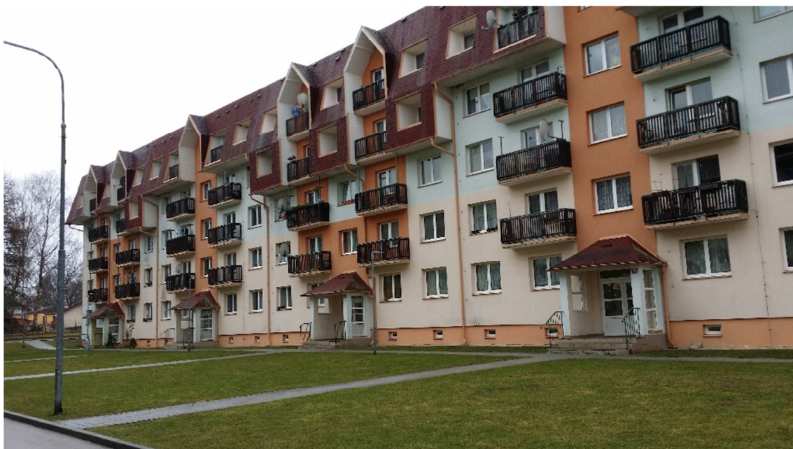
Obr.2 – Pohled na posuzované vstupy bytových domů v lokalitě Kuřívody
