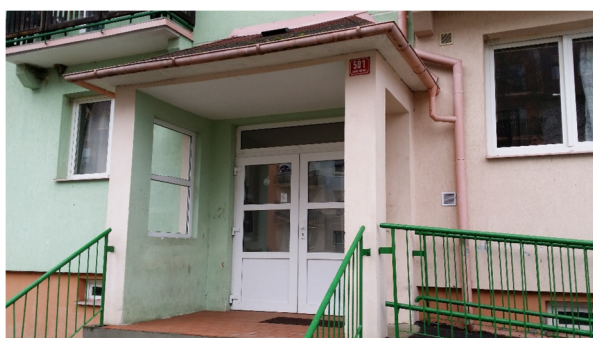
Obr.4,5,6,7 – Pohled na posuzované vstupy bytových domů v lokalitě Kuřívody – trhliny a otevřené spáry mezi podhledem a svislými konstrukcemi a obvodovým pláštěm a svislými konstrukcemi
