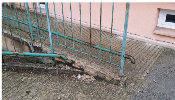
Obr.8,9,10,11,12,13 – Pohled na posuzované vstupy bytových domů v lokalitě Kuřívody – degradace betonů a dlažeb na přístupovém schodišti a rampách
