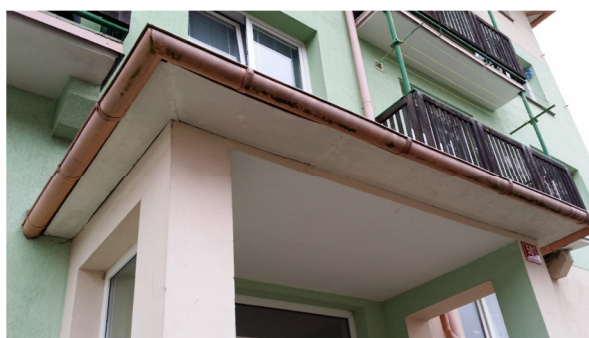
Obr.4,5,6,7 – Pohled na posuzované vstupy bytových domů v lokalitě Kuřívody – trhliny a otevřené spáry mezi podhledem a svislými konstrukcemi a obvodovým pláštěm a svislými konstrukcemi
