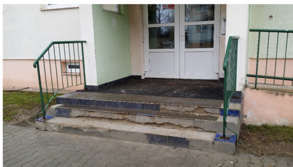
Obr.8,9,10,11,12,13 – Pohled na posuzované vstupy bytových domů v lokalitě Kuřívody – degradace betonů a dlažeb na přístupovém schodišti a rampách
