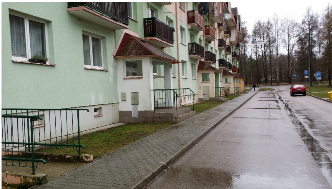
Obr.3 – Pohled na posuzované vstupy bytových domů v lokalitě Kuřívody
