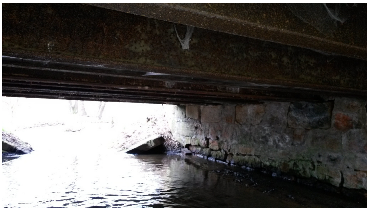
Obr.6 – Pohled na most – nosná konstrukce s korozí
