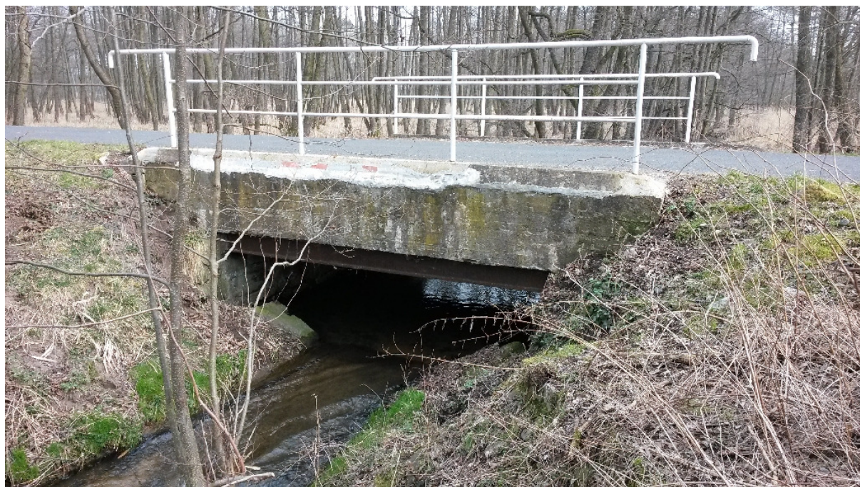
Obr.3 – Pohled most z výtokové strany
