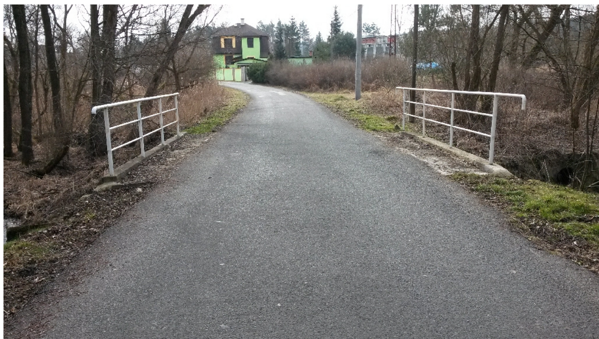
Obr.2 – Celkový pohled na most směrem objekt č.p.953
