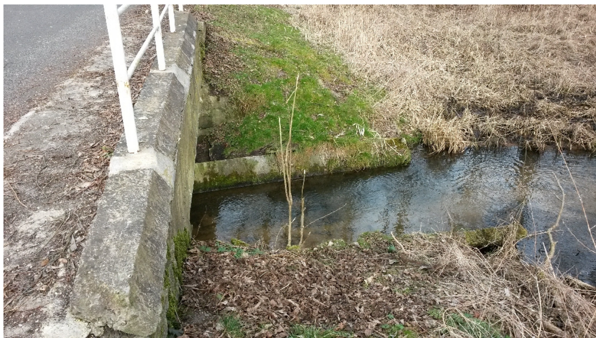
Obr.4 – Pohled na most z nátokové strany
