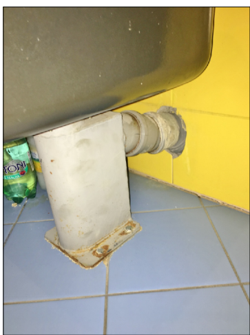
pod výlevkou bude provedeno napojení nového umyvátka na kanalizaci
