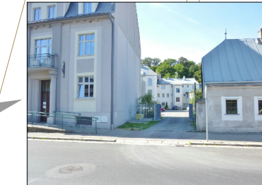
likvidace rampy v rámci rekonstrukce chodníku (není předmětem této PD)
