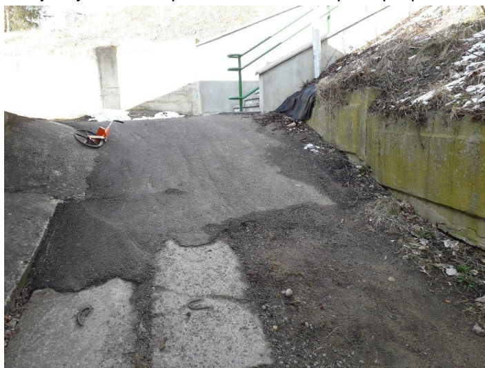
styk živičního krytu s betonovými panely
