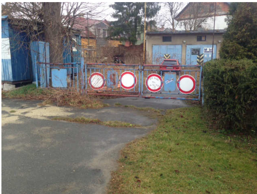
Pohled na místo stavby
