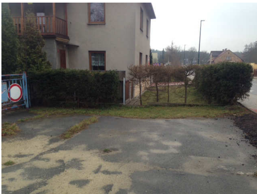
Pohled na místo stavby
