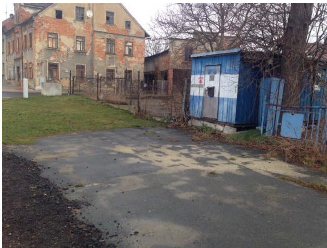
Pohled na místo stavby
